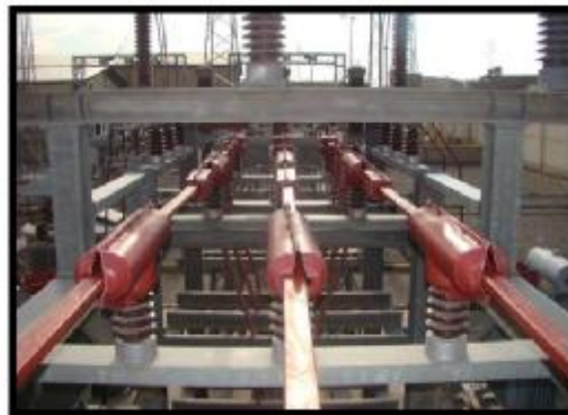
شکل 11: عایق نمودن تجهیزات داخل پست
