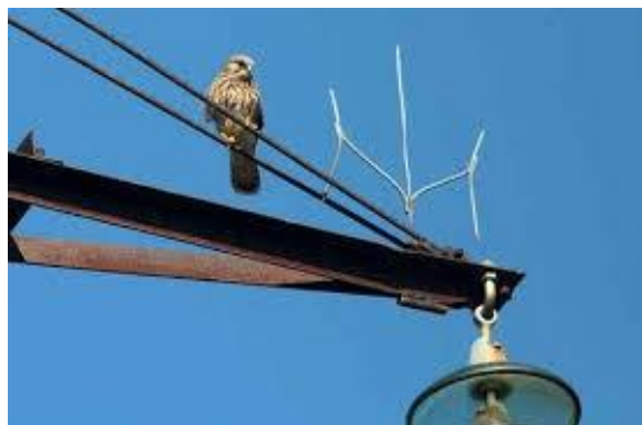
شکل 6: روشی جهت ممانعت از نزدیک شدن پرنده به فاز
