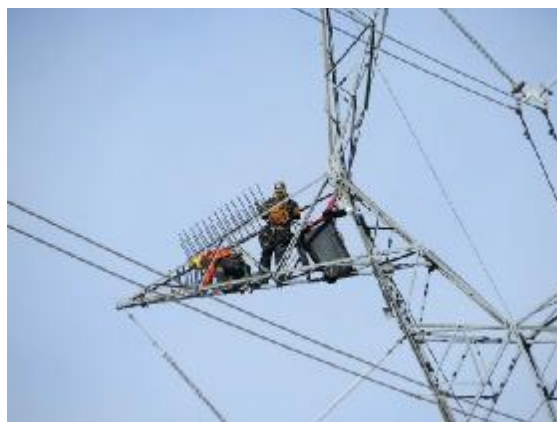
شکل 8: روشی جهت ممانعت از نزدیک شدن پرنده به فاز
