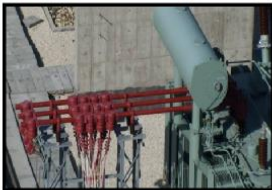
شکل 11: عایق نمودن تجهیزات داخل پست
