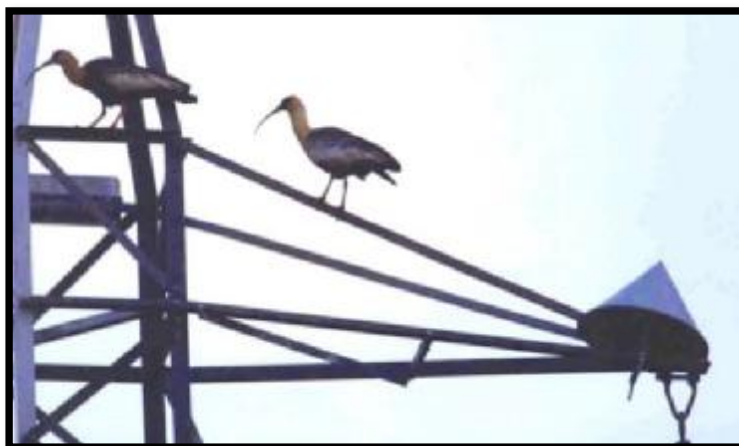
شکل 5: روشی جهت ممانعت از نزدیک شدن پرنده به فاز
