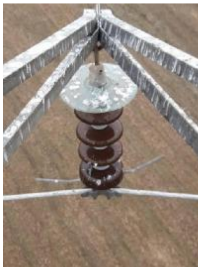
شکل 3: نمونه ای از آلودگی مقره ها به فضولات پرندگان و راه کار پوششی
