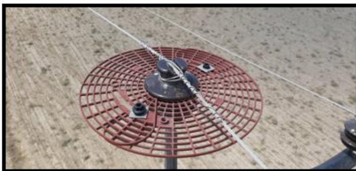
شکل 28: نصب بشقابک عایق سیلیکونی برای ممانعت از برخورد پرنده با شبکه برقدار و راس تیر
