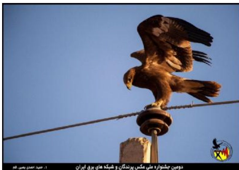
شکل 17: خطر برق گرفتگی در راس تیر شبکه فشار متوسط و احتمال بروز اتصالی فاز به زمین
