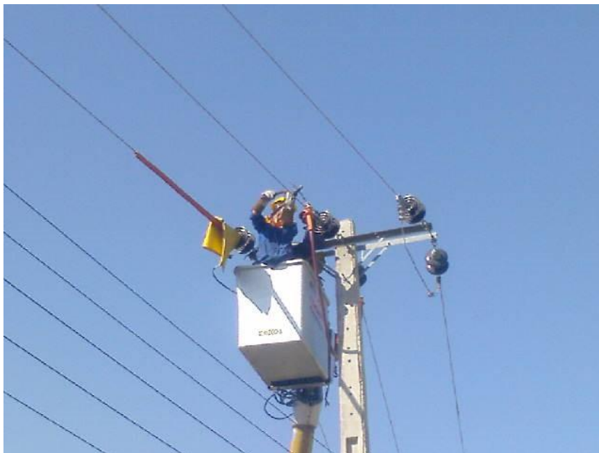
شکل 38: اجرای عملیات خط گرم جهت اصلاح جامپرهای غیر استاندارد
