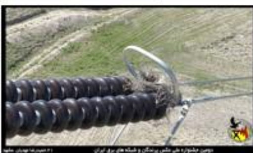
شکل 56: نمونه هایی از لانه های ساخته شده توسط پرندگان روی شبکه
