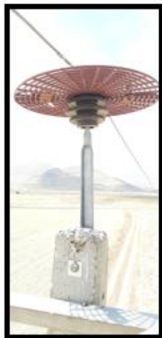
شکل 28: نصب بشقابک عایق سیلیکونی برای ممانعت از برخورد پرنده با شبکه برقدار و راس تیر
