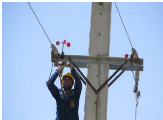
شکل 46: پرنده پران نصب شده روی کنسول
