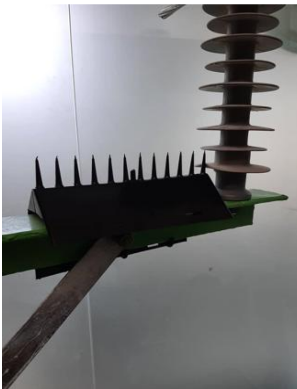
شکل 30: خار دور کننده پرند جهت جلوگیری از نشستن پرند روی کراس آرم و نزدیک شدن به فاز
