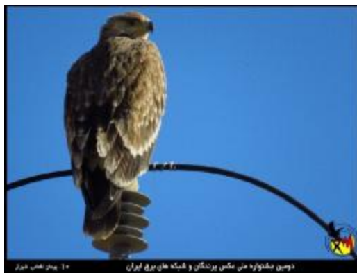
شکل 25: استفاده از جمپر با روکش عایق
