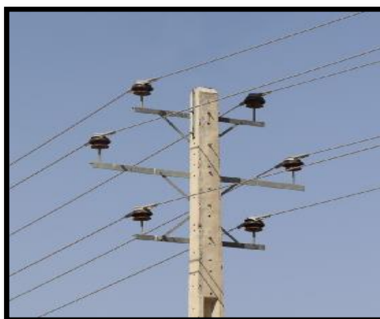
شکل 26: سه کراس آرم افقی جایگزین مناسب به جای دو کراس آرم
