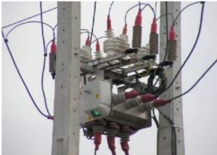
شکل 44: عایق‌سازی رابط‌ها جهت جلوگیری از پرنده‌زدگی
