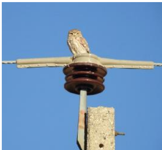
شکل 45: عایق سازی هادی راس تیری جهت جلوگیری از پرنده زدگی
