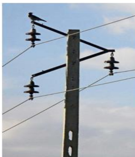
شکل 29: استفاده از آرایش مقره آویز جهت جلوگیری از پرنده‌زدگی بواسطه افزایش فاصله بین پرنده و هادی شبکه
