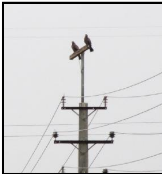
شکل 27- نصب سکوی نشیمنگاه پرندگان جهت دور بودن پرندگان از شبکه برق دار
