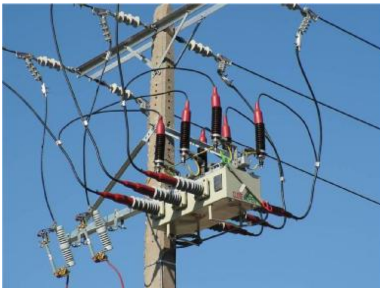
شکل 43: عایق‌سازی رابط‌ها جهت جلوگیری از پرنده‌زدگی
