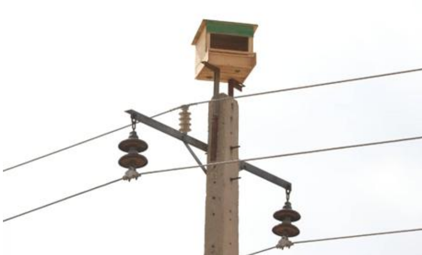
شکل 58: نمونه لانه نصب شده روی شبکه فشار متوسط
