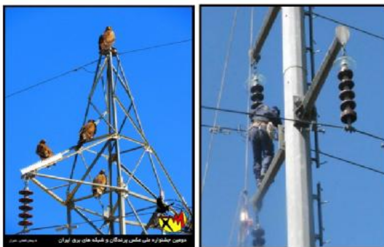
شکل 10: راهکارهای جلوگیری از نزدیک شدن پرنده به فاز و استفاده از مقره‌های آبرو دینامیک
