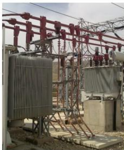
شکل 12: عایق نمودن تجهیزات داخل پست
