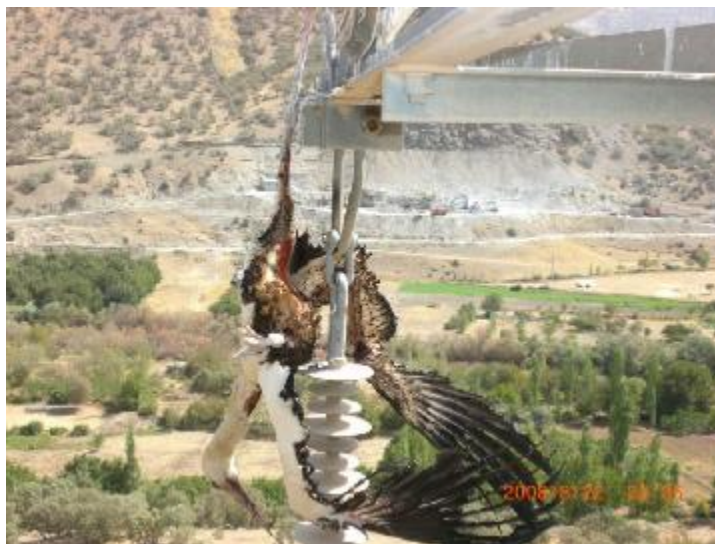
شکل 4: نمونه ای از گیر کردن پای پرنده در یراق آلات خطوط هوایی
