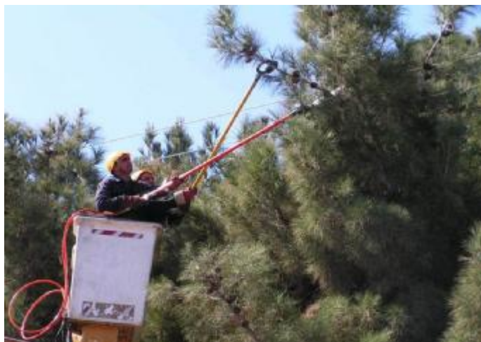
شکل 39: شاخه زنی به روش خط گرم
