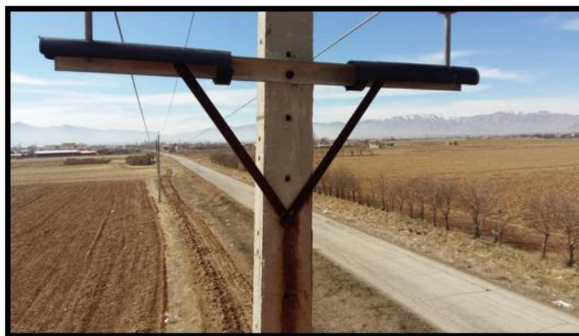
شکل 34: عایق کردن کراس آرم با استفاده از لوله های پلی اتیلین فشار قوی و یا کاورهای سیلیکونی
