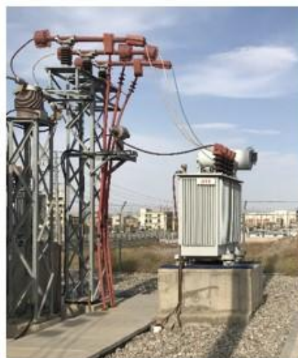
شکل 12: عایق نمودن تجهیزات داخل پست
